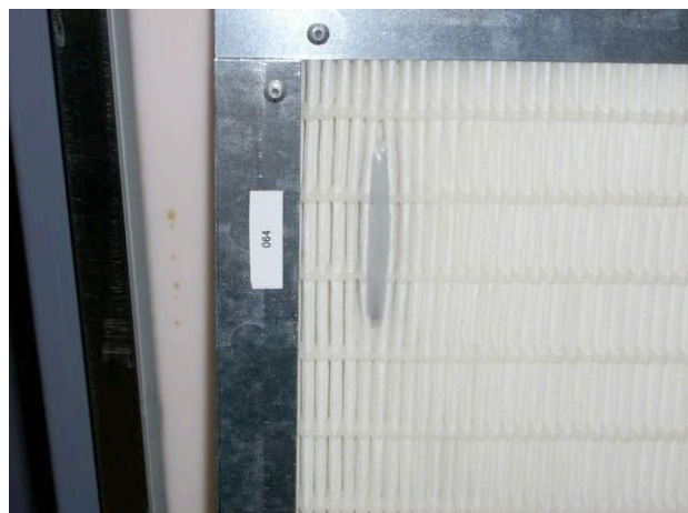
RFIDタグ取り付け状態
