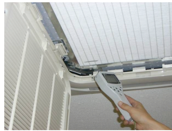
RFIDタグを読み取り空調機との紐付け
